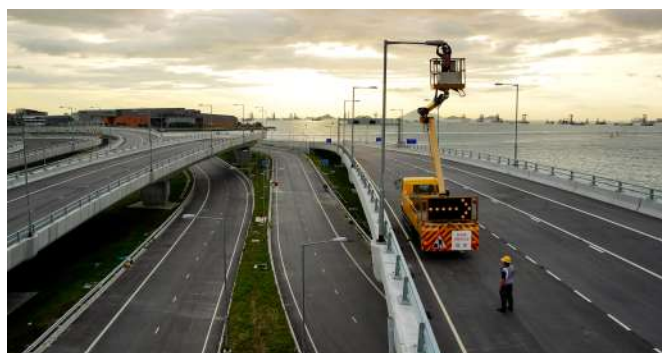
■ 為路政署公共照明系統更換LED燈具，節省電力及提升照明效能。
