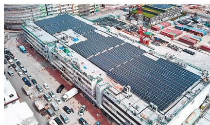
位於土瓜灣總部的新寶天台大太陽能板項目，團隊利用建築信息模擬 (BIM) 技術，準確計算出最合適的一站式太陽能系統方案，為推動減碳出力。
